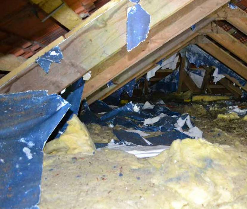
In den 1990er Jahren neu gedeckt wurde bei der damaligen Maßnahme eine Unterspannfolie verwendet, die innerhalb weniger Jahrzehnte zu Fetzen und Staub zerfallen ist, vermutlich durch UV-Schaden. Dadurch muss nun das gesamte Dach neu eingedeckt werden, die alten Ziegel werden wiederverwendet.
